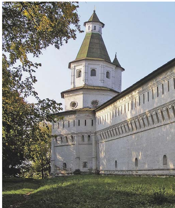
Гефсиманская башня и часть крепостной стены с бойницами
